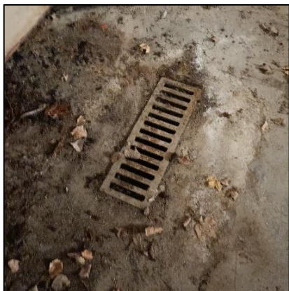
Avaloir au-dessus de l'ancien lavoir a priori remblayé (bassin de décantation des effluents industriels ?)
